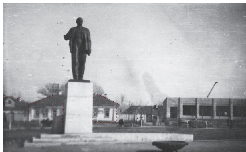
1964-1966 Строительство здания телеграфа на площади Ленина
